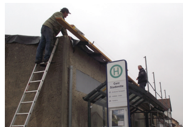
Vereinsmitglieder decken das Dach ihres Vereinshauses neu ein
