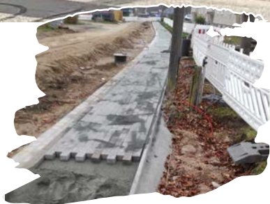
Neues aus Garz aktuelle Baustellen
