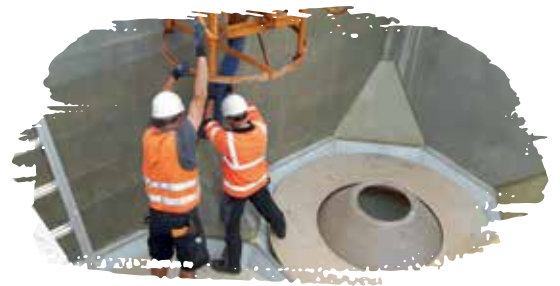
Bau der Zusatzfiltration auf der Kläranlage Bergen
