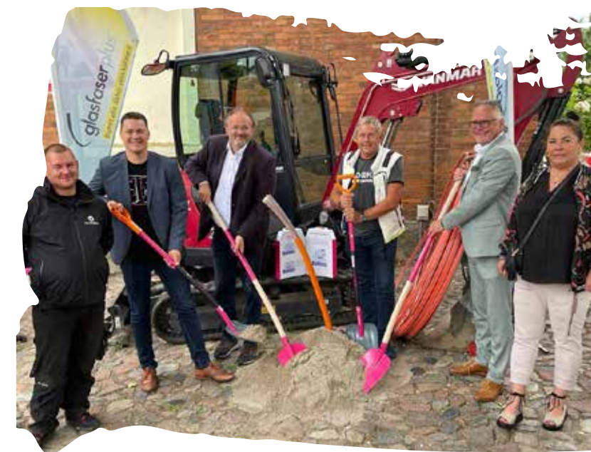
Spatenstich am 28. Juni
