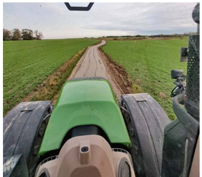
Ländlicher Wegebau: Rosengarten-Strand und Dumsewitz-Hafen bleiben noch für einige Zeit gesperrt für Fahrzeuge, damit sich der Straßenkörper setzen kann.
